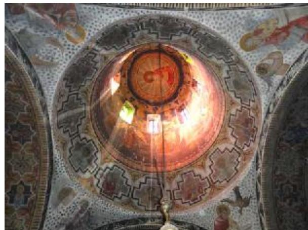
**Fig. 32.** Biserică „Sf. Vasile”, satul Domnu Tudor, jud. Dolj – modul de reducere a diametrului interior al tamburului pe care se sprijină cupola aplatizată pe zona naosului, la ferestrele turlei folosește sticlă diferit colorată, în funcție de orientarea cardinală, care filtrează razele soarelui și creează lumina necesară meditației la diferitele momente ale zilei
