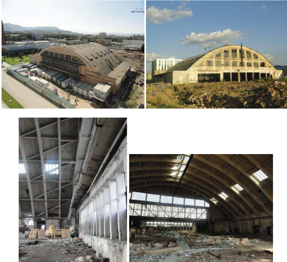
Fig. 21. Hala de montaj – august 2017 – vederi exterioare (fațada principală și fațada posterioară – se observă demolarea barei lateral-stânga – în vederea posterioară, bară în care erau amenajate birourile de studii, construită după proiectul arh. Octav Doicescu din 1937-1938) și vederi interioare ale arcelor parabolice și ale luminatoarelor – arhiva personală
