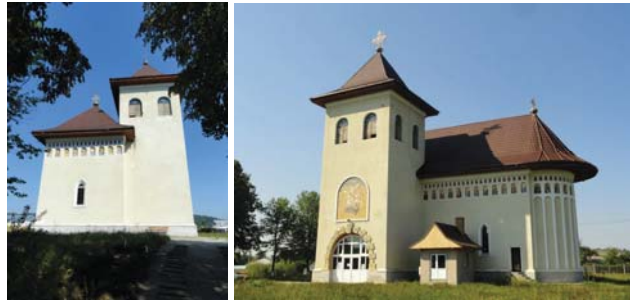
Fig. 16. Biserica „Sf. Gheorghe” – Tescani, com. Berești-Tazlău, jud. Bacău – vedere a laturii de vest și vedere dinspre sud-est (închiderea golului de acces în turnul clopotniță cu tâmplărie PVC alb și geam termopan și construcția mică de pe latura de sud a bisericii sunt intervenții de dată recentă), august 2015 – arhiva personală
