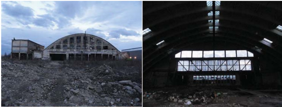
Fig. 20. Hala de montaj – ianuarie 2016 – vedere exterioară (fațada posterioară) și vedere interioară - arhiva personală
