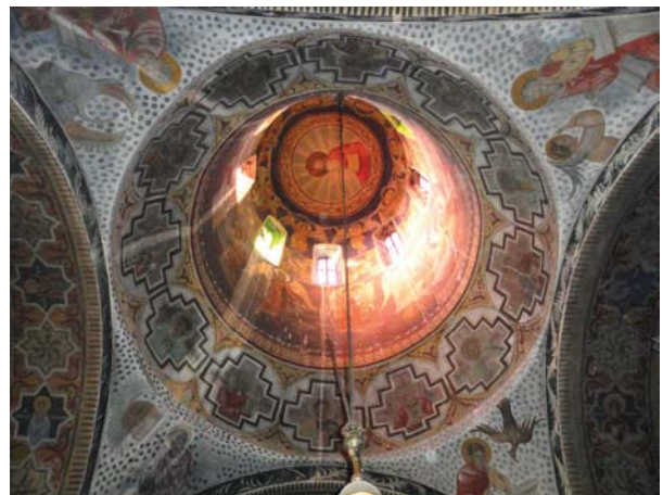
Fig. 32. Biserica „Sf. Vasile”, satul Domnu Tudor, jud. Dolj – modul de reducere a diametrului interior al tamburului pe care se sprijină cupola aplatizată pe zona naosului, la ferestrele turlei folosește sticlă diferit colorată, în funcție de orientarea cardinală, care filtrează razele soarelui și creează lumina necesară meditației la diferitele momente ale zilei
