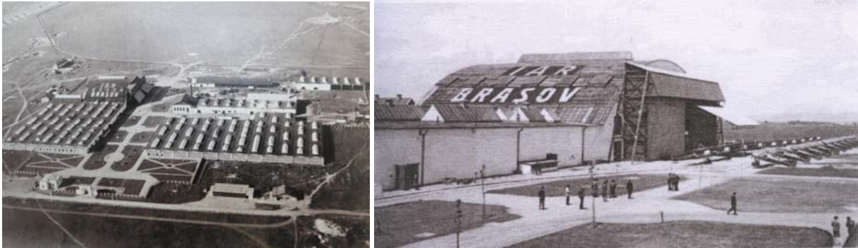
Fig. 19. Ansamblul Fabricii de avioane IAR Brașov - vedere aeriană 1932, Hala de montaj – 1927, Arhiva ing. Traian Tomescu
