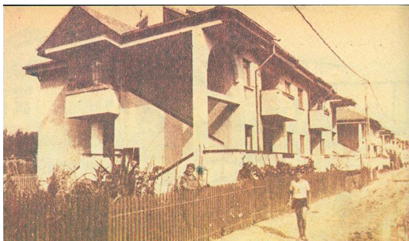
Fig. 1. Case cu parter și etaj construite în centre agroindustriale în proiectul de sistemizare 8 .
